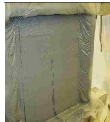
(d) GFRP-Polyurea Retrofit
