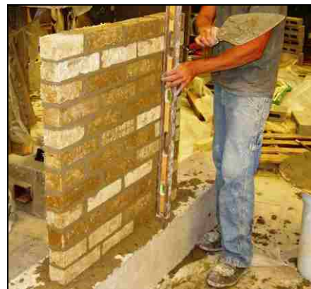
(d) Completed Wall
