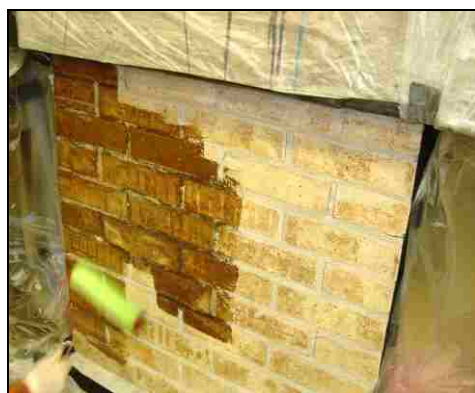
(a) Application of Primer
