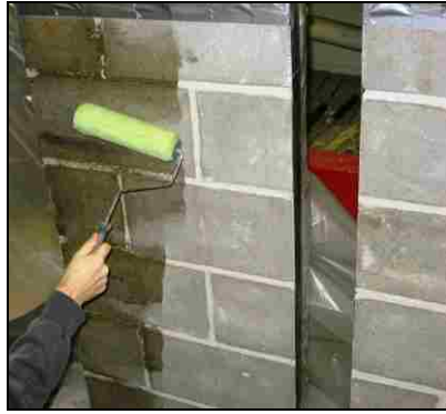
(a) Application of Primer
